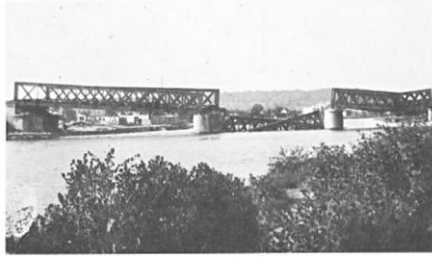
Pierre Lambert La plupart des convois de déportés passèrent sur ce pont de la ligne de Soissons
